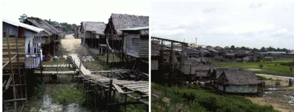
Figura 2: Casas sobre pilotes (izquierda) y casa flotante (derecha) en el barrio de Belén (Iquitos). Fotos: © IRD/Ronchai, Josyanne.
