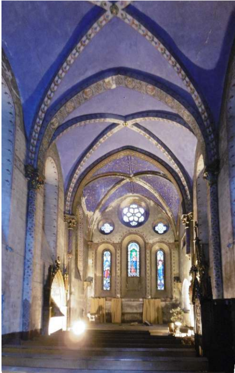
Fig. 4. – Chapelle de la Visitation à Clermont-Ferrand (Puy-de-Dôme), voûtement de la nef.
