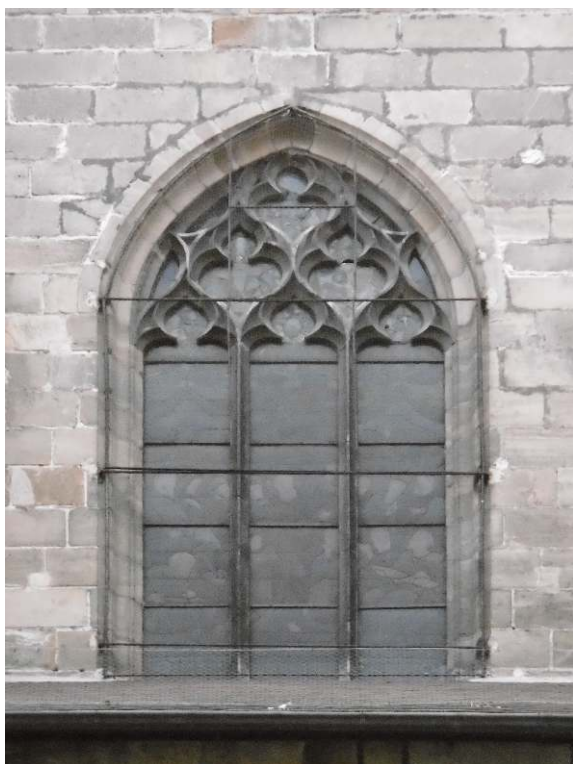
Fig. 7. – Église Saint-Pierre-des-Carmes à Moulins (Allier), baies flamboyantes de la nef.
