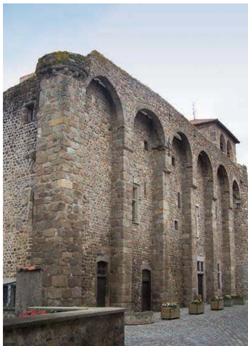
Fig. 290 - Mâchicoulis sur arcs sur le mur nord du prieuré.
