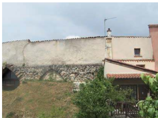
Fig. 293 - Arcs de décharge dans les maçonneries de l'enceinte du bourg.
