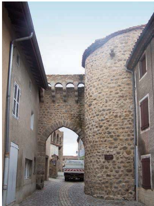
Fig. 291 - La porte nord-ouest de l'enceinte du bourg, dite « Porte de Bise ».
