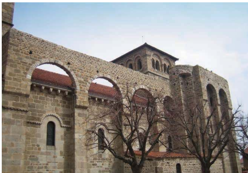
Fig. 287 - Le mur gouttereau sud de l'église priorale et ses mâchicoulis sur arcs.
