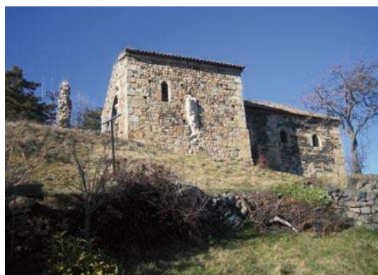
Fig. 273 - Vue de la façade nord de la chapelle.
