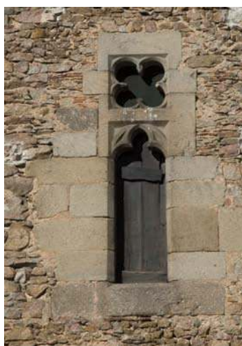
Fig. 153 - Détail d'une des baies polylobées de la camera.
