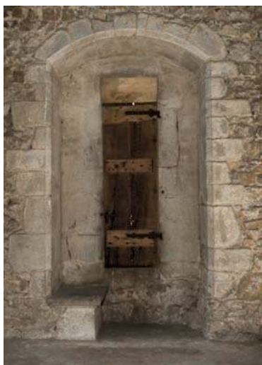
Fig. 155 - Baie à coussiège dans la camera.
