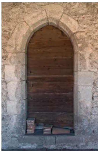
Fig. 156 - Porte d'accès à la camera depuis la galerie de bois au second niveau.
