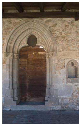
Fig. 157 - Porte d'accès à la chapelle depuis la galerie de bois au second niveau.
