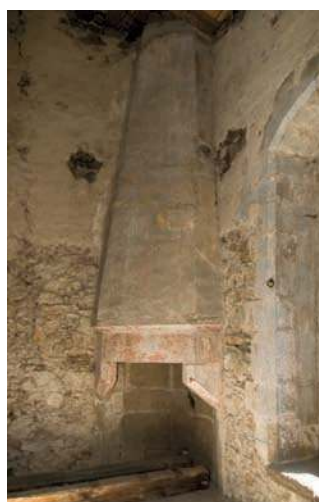
Fig. 154 - Cheminée d'angle dans la camera.
