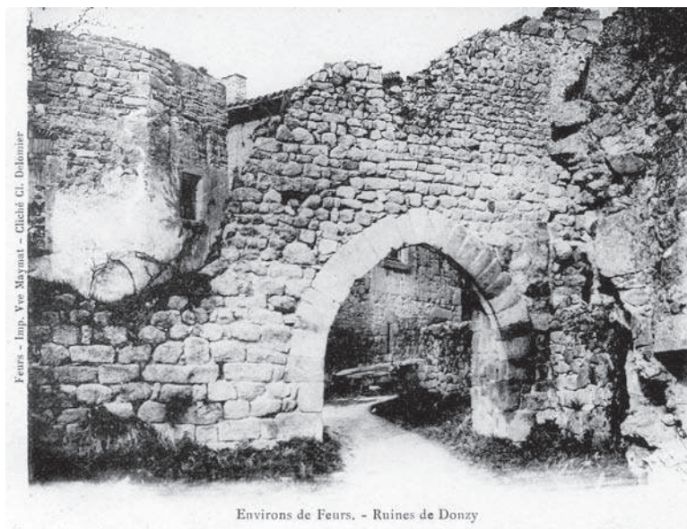
Fig. 106 - Porte et logis de la basse-cour au début du XX e siècle (collection privée)
