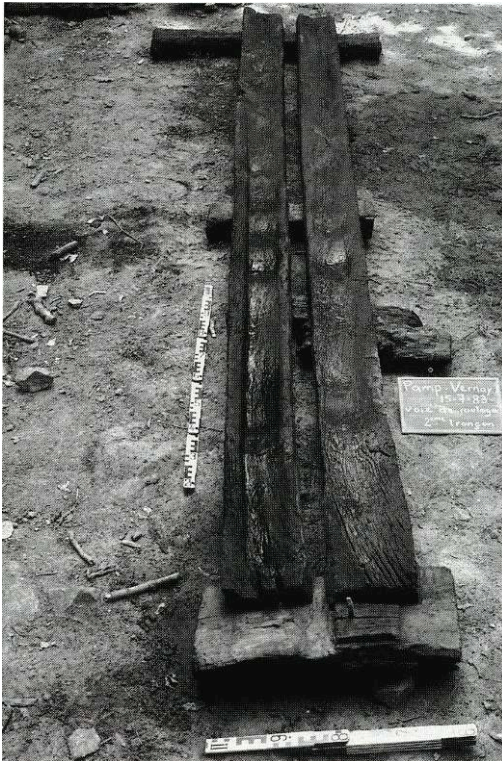
64 - Partie terminale de la voie de roulage du XVIIIe s. déposée et remontée
