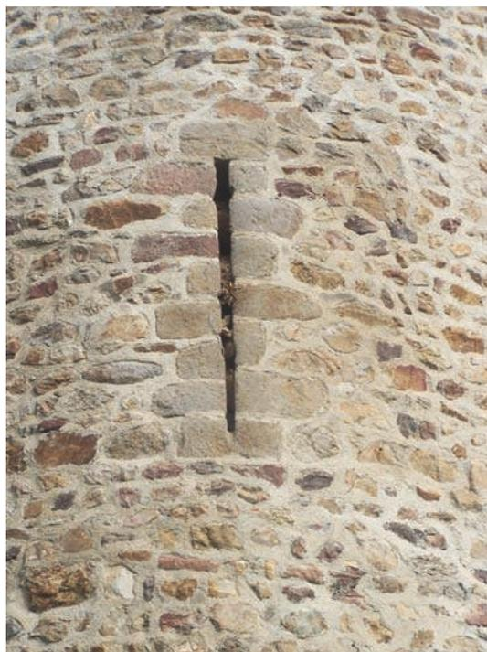
Fig. 409 - Vue de détail d'une archère d'une tour de flanquement.
